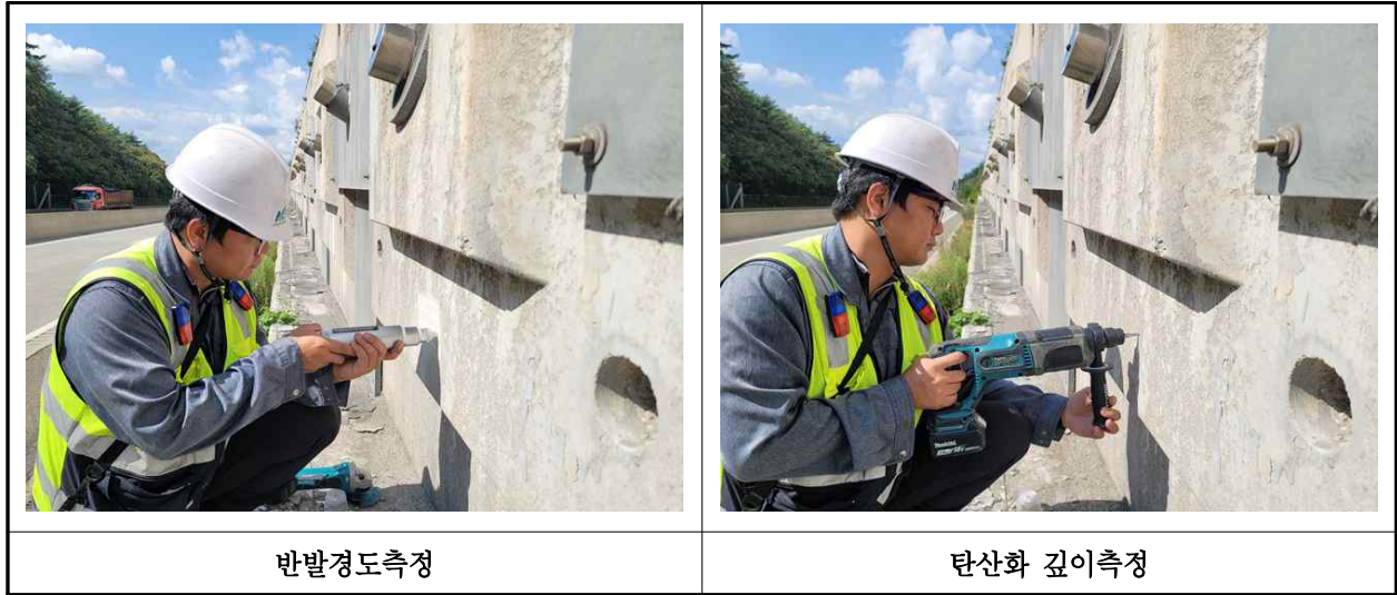
【사진 10.4.1】 재료시험 조사 전경
