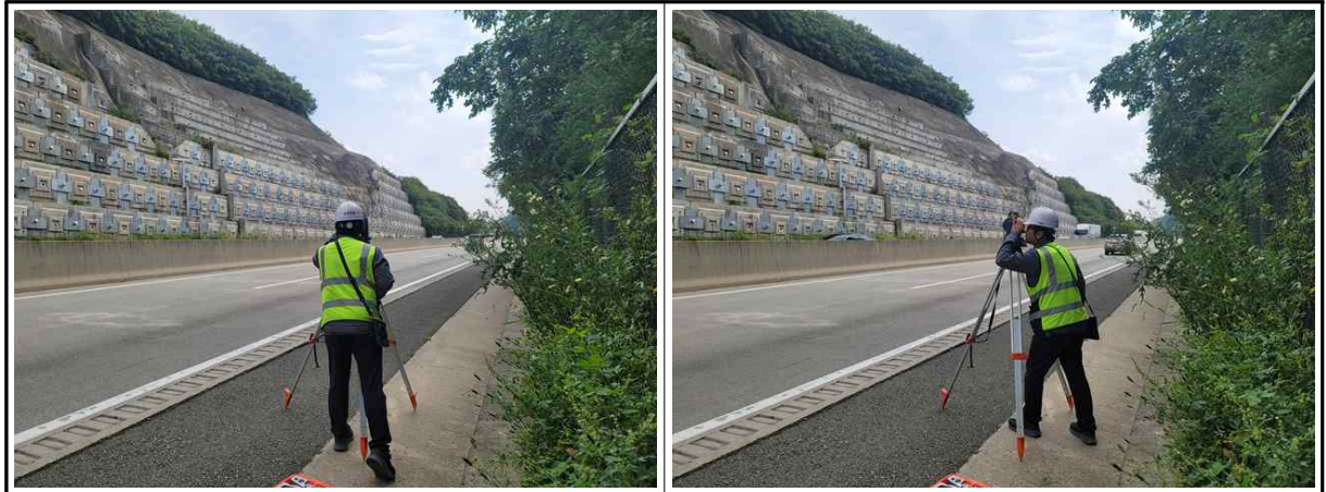
【사진 10.4.2】 측량작업 전경
