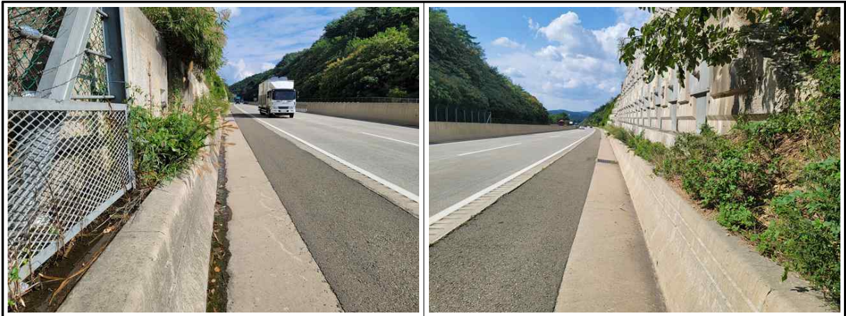
【사진 10.3.1】 지반, 기초부 전경
